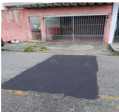
Resolução: Reposição Asfáltica
