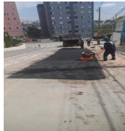
Resolução: Infiltração e vazamento saneados
